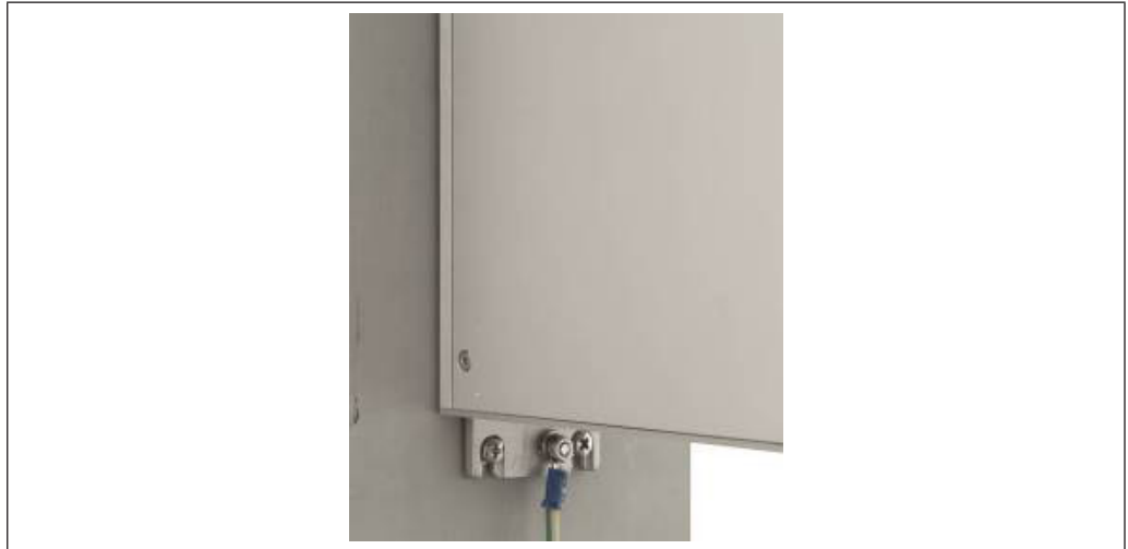
Abbildung 37: Anschließen der Erdungskabel
