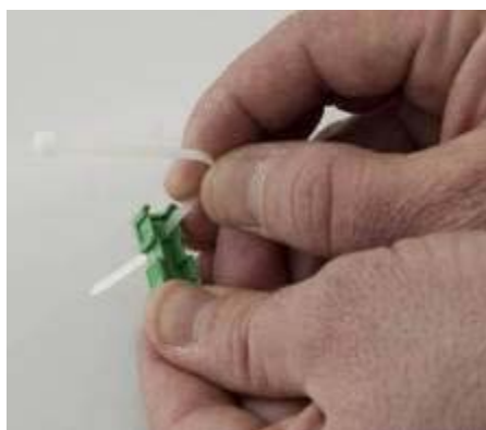
Abbildung 52: Montage Leistungssteckverbinder
